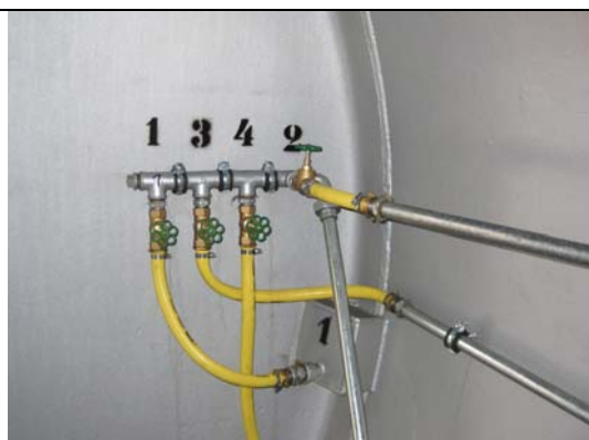
Verteilerarmatur im Inneren des Kesselwagens (Leck 1-4)
